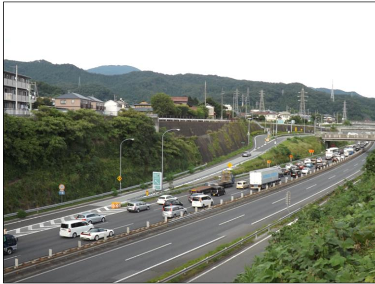
写真3 中央自動車道（上野原インターチェンジ、2015年7月撮影）
